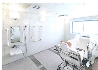
チェアインバスを設置した浴室
